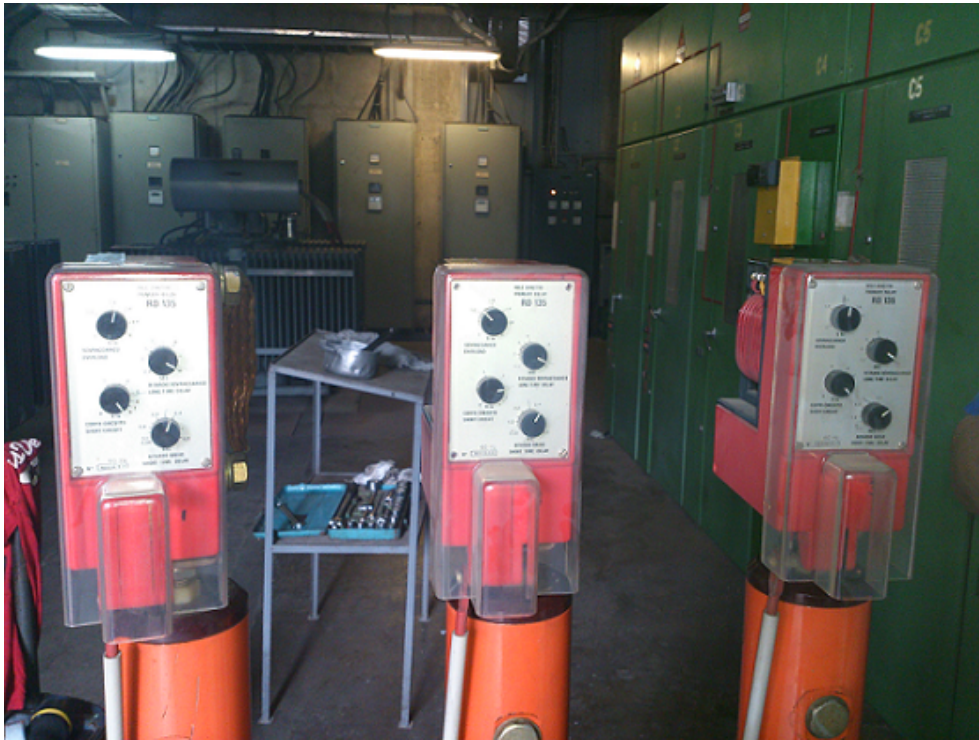
Figura B.5: Tres relés de media tensión FIR-135, uno por polo.
